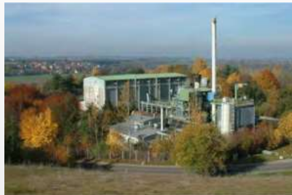
Instalacja Burgau, Niemcy – 30 000 Mg MSW/rok
