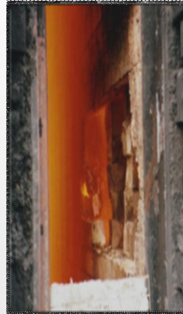
Wyłamanie ściany grzewczej o znacznej wysokości na kilku kanałach grzewczych
