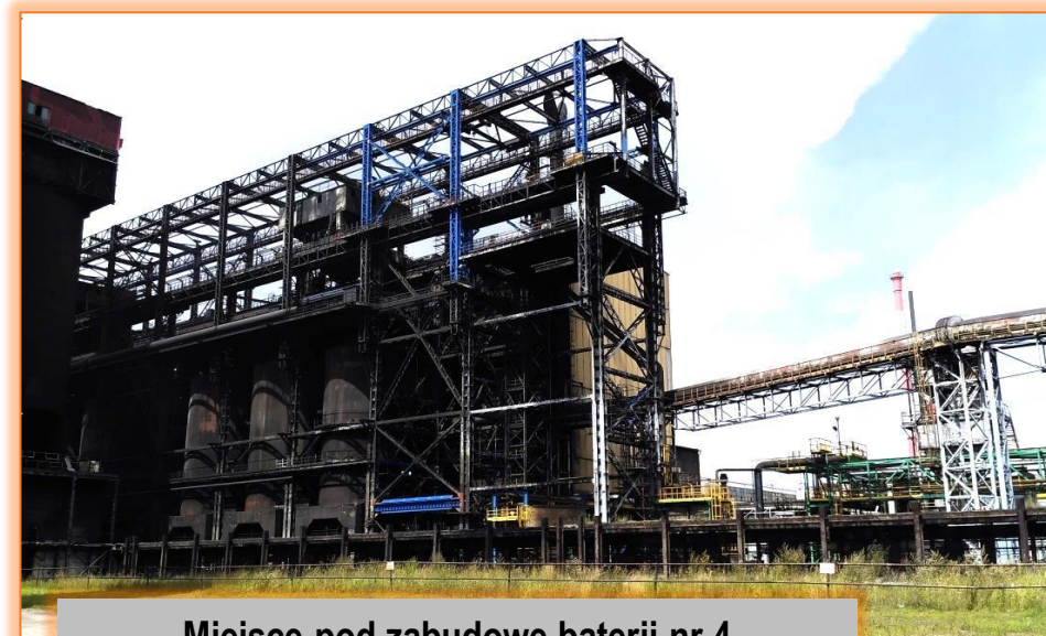
Miejsce pod zabudowę baterii nr 4
