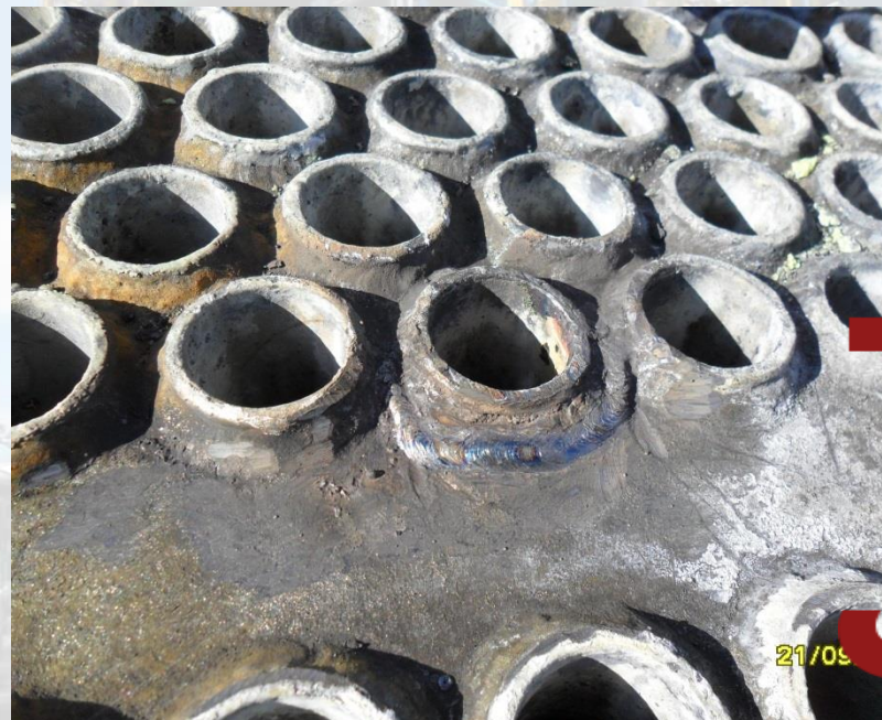
naprawione miejsce nieszczelności w podgrzewaczu gazu procesowego
