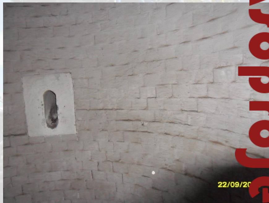
wymurówka ścian reaktora NH_3
