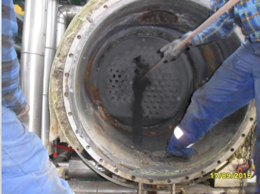
czyszczenie rur kotła NC
