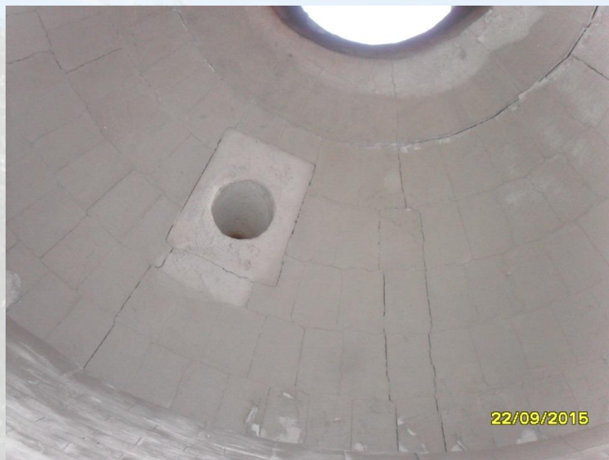
wymurówka kopuły reaktora NH_3
