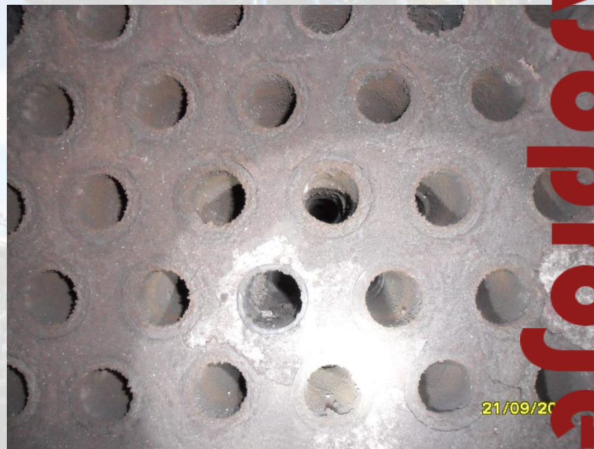
wymurówka ściany sitowej kotła WC.
