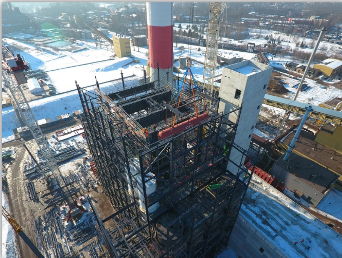
Stan budowy na 24.01.2017 r.
