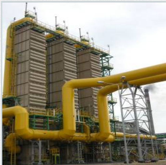
Chłodnice końcowe, instalacja Claus, kolumny zintegrowane
