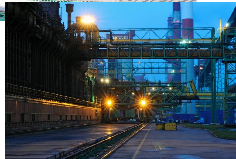
Bateria nr 5 Koksownia Przyjaźń
