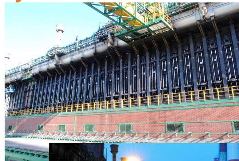
Bateria nr 1 Koksownia Przyjaźń
