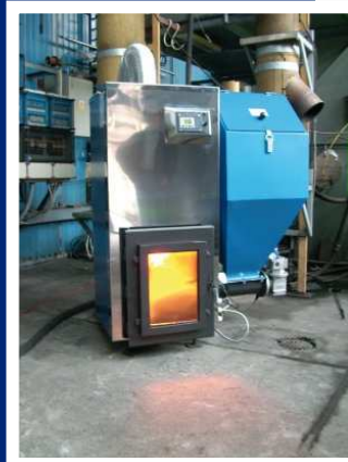
kocioł z automatycznym ciągłym podawaniem paliwa
