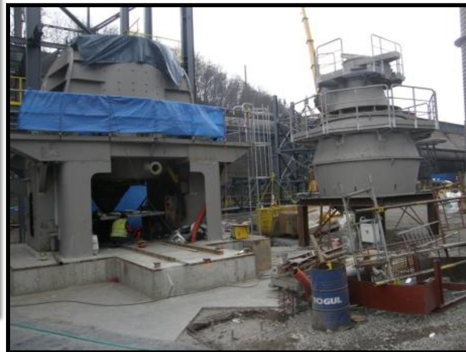
Młyn walcowy - fundamenty
